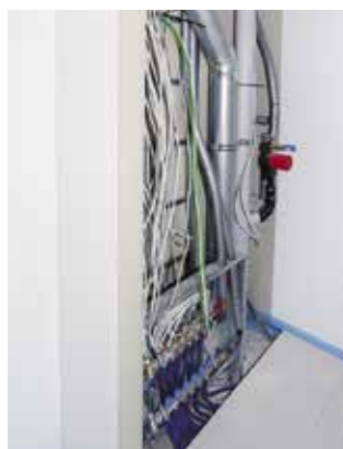
Vorgefertigte Installationen
