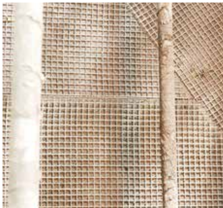
Wegen der geringen Gesamtdicke der Mörtelschutzschicht wird die Carbonbewehrung nicht überlappend verlegt, sondern stumpf aneinandergestoßen.
