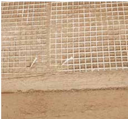
Das vorbereitete Textilgewebe wird direkt in die noch frische Schicht eingelegt, ausgerichtet und durch leichtes Andrücken fixiert.
