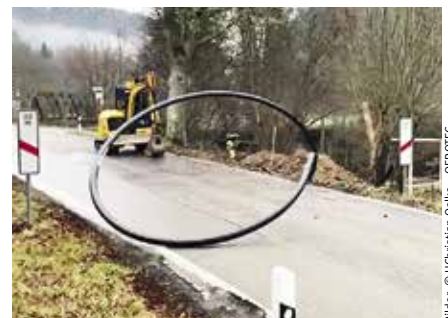
Ende des Rohrmaterials kurz nach dem Herausschlagen
