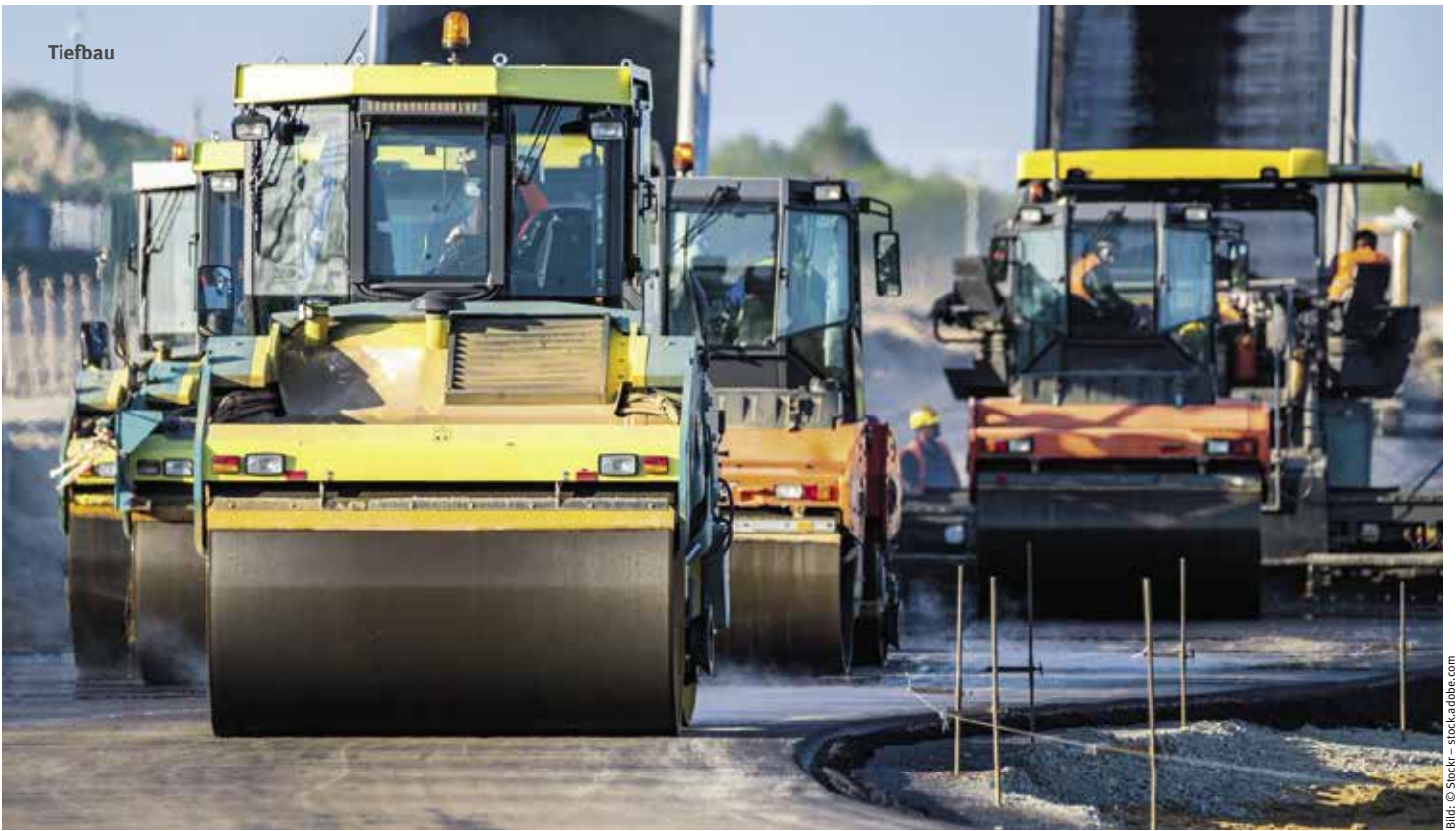
Asphaltkolonne im Einsatz
