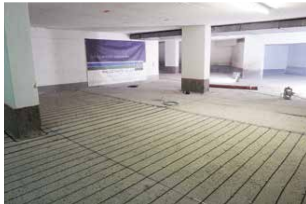
Instandsetzung eines Parkhauses mit kKS
