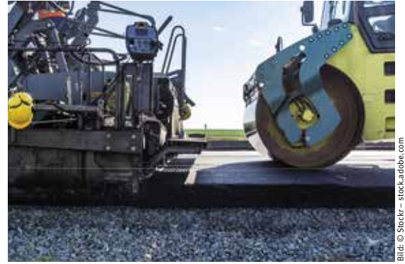
Fertige Asphalttragschicht am Ende einer Arbeitsschicht
