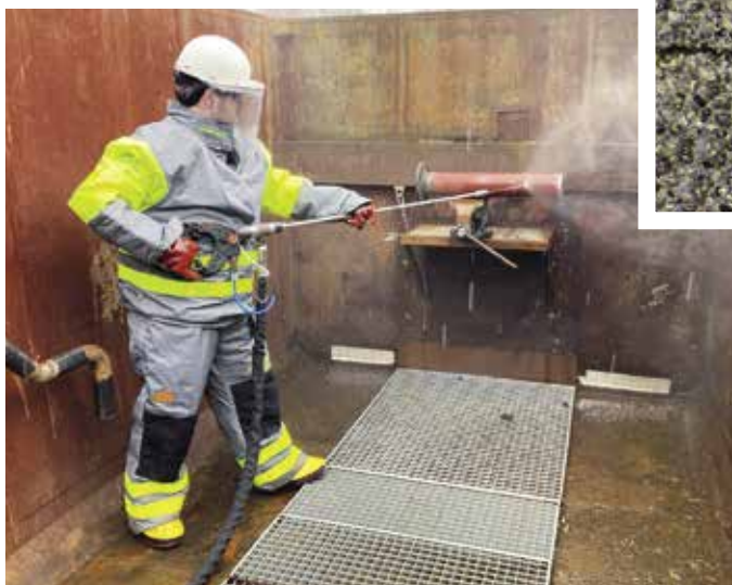
Abb. 5: Beispiel für die Schutzkleidung bei der Arbeit mit Hochdruckwasserstrahl aus der Praxis
