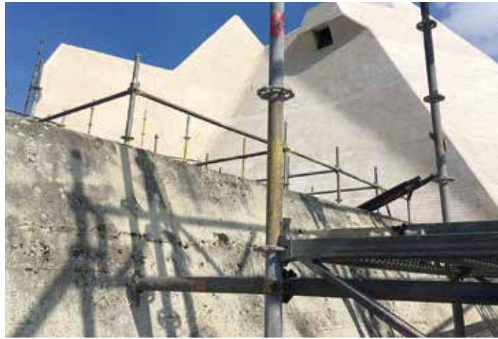
Bild: © Ed. Zublin AG Direktion Bauwerkserhaltung
