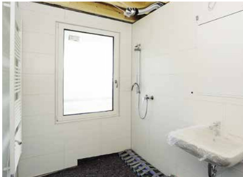
Sanitärzelle mit Fenster
