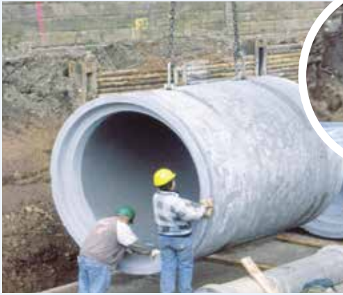
Anker im Scheitel des Rohrs
