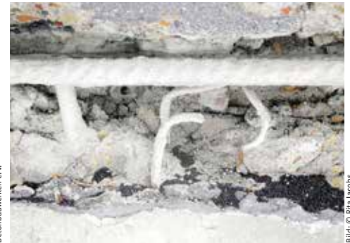
Behebung von Schäden: Vor der Reprofilierung wurde ein mineralischer Korrosionsschutz auf die entrosteten Bewehrungsstähe aufgebracht.
